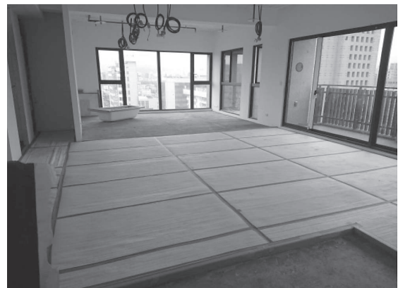
「清歓」施工中のマンションの様子
